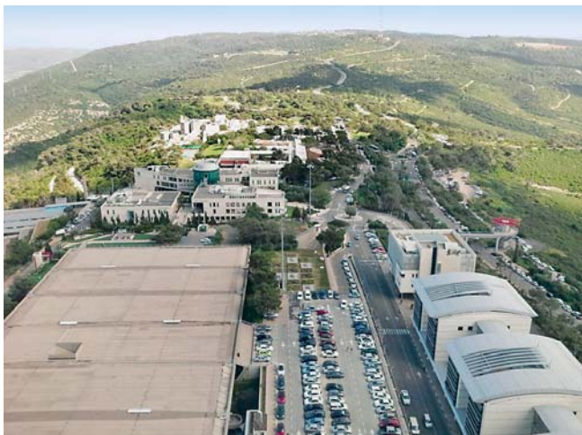
Pogled s najvišeg kata glavne zgrade na Sveučilišni kampus.
