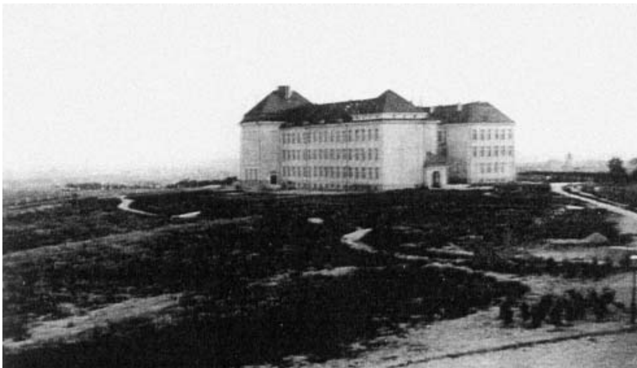
Zgrada starog Dekanata u pustoši Širokog brijega
