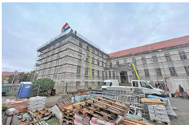
Postavljeno je krovništvo
