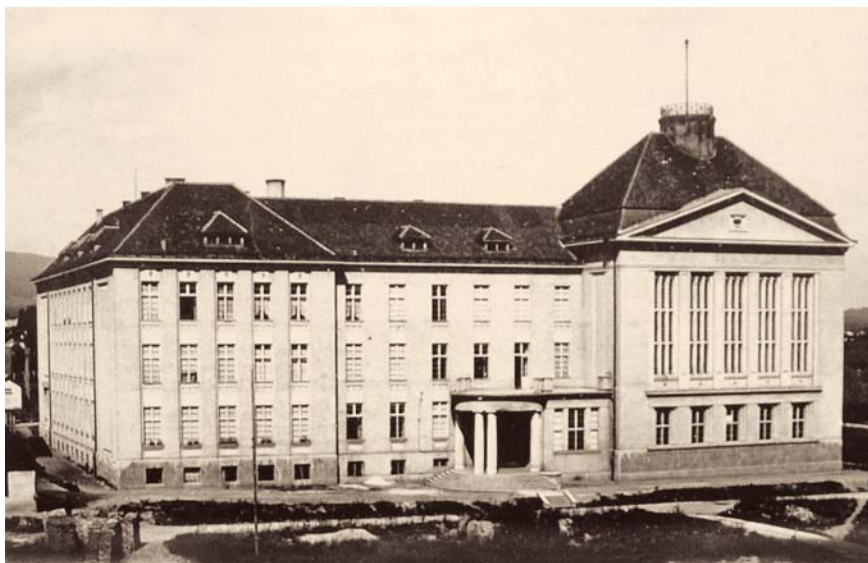
Zgrada dekanata (bivša gimnazija) (Vladimir Dugački, arhiva)
