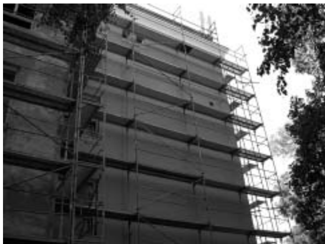
Zgrada Škole narodnog zdravlja - veliko gradilište. Nakon osiguranja stabilnosti zgrade u tijeku su radovi na uređenju pročelja i unutrašnji radovi.
