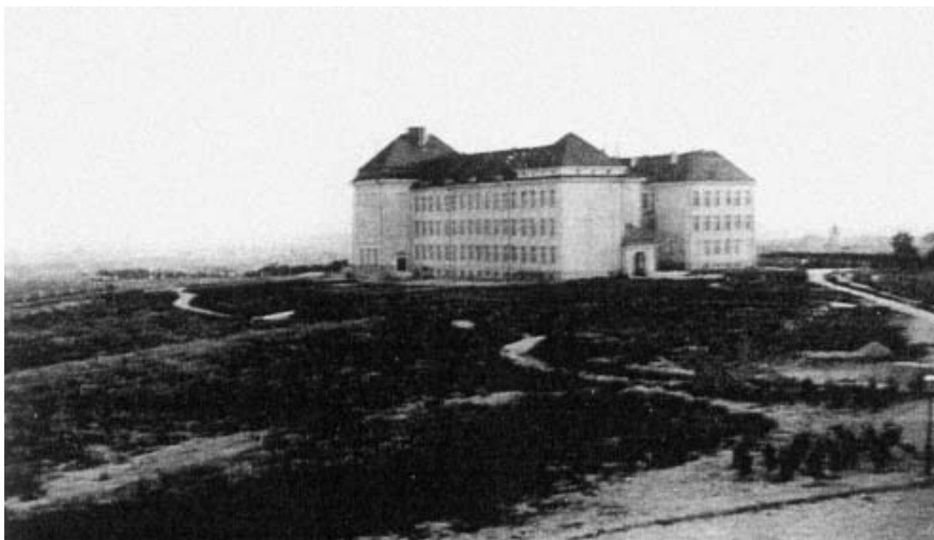
Zgrada starog Dekanata u pustoši Širokog brijega
