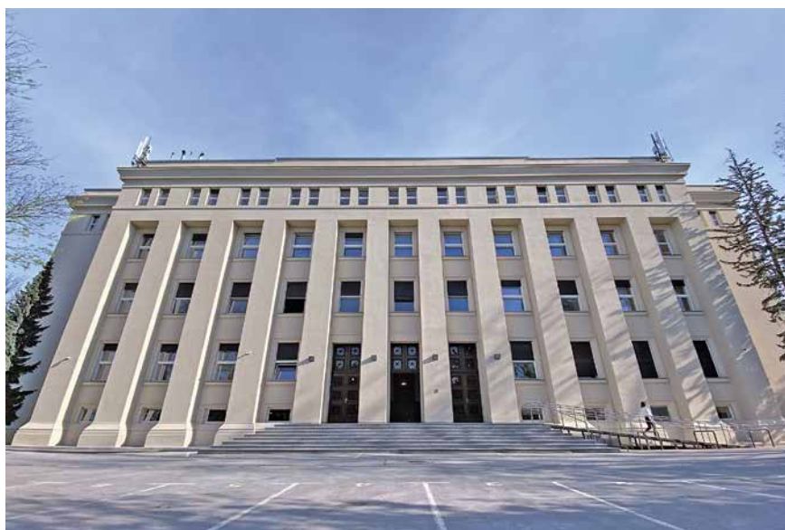
Obnovljena zgrada Škole narodnog zdravlja „Andrija Štampar“
