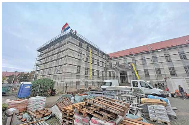
Postavljeno je krovništvo
