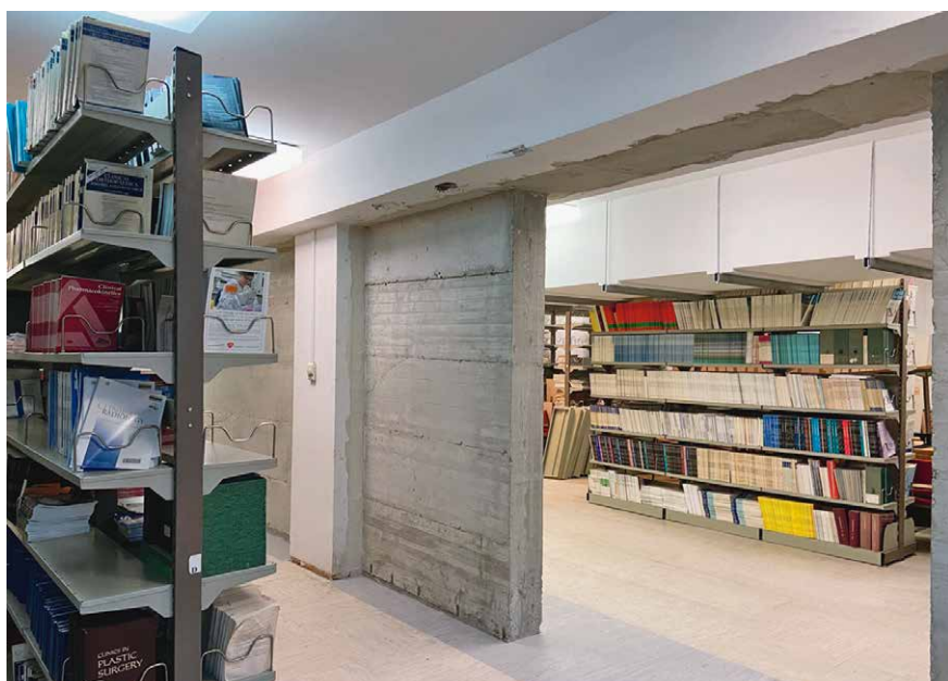
Sanacija prostora u zgradi Dekanata, Šalata 3b već je u odmakloj fazi. Na gornjoj slici - dekan Fakulteta s izvođačima radova
