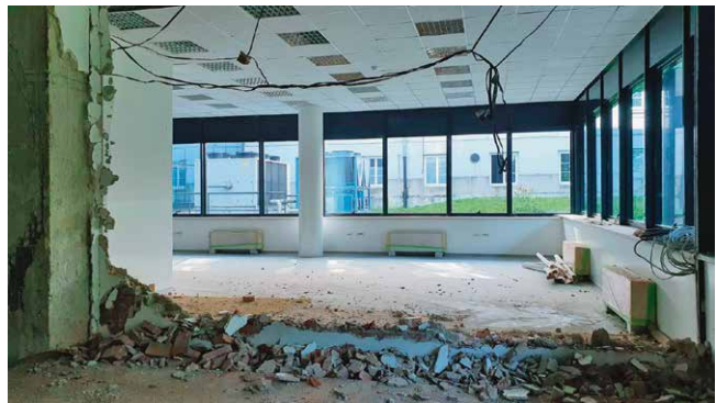
Radovi u knjižnici (kolovoz 2020.)
