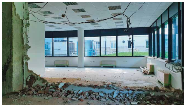
Radovi u knjižnici (kolovoz 2020.)
