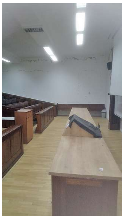
Predavaonica Zavoda za farmakologiju s oštećenjima na zidu od potresa u Zagrebu 2020. godine
