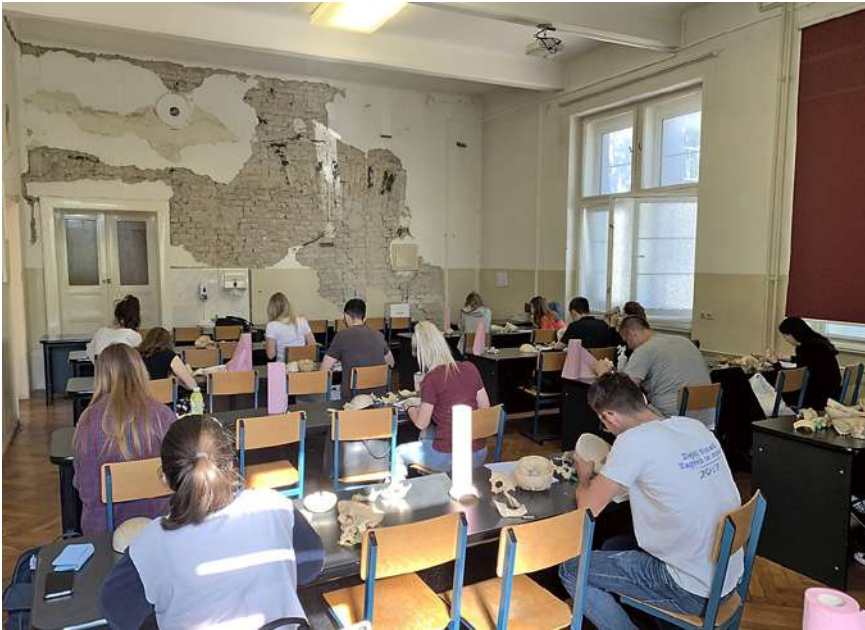
Povratak studenata na izravnu nastavu u oštećenim prostorima Zavoda
