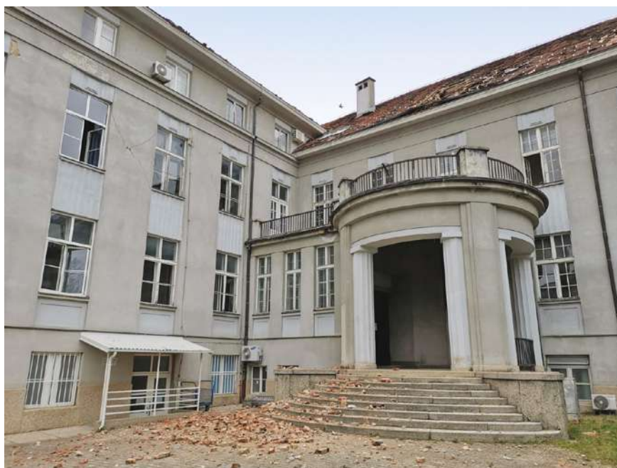
Križne pukotine ispod EM centra
