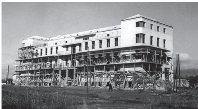
Izgradnja Ortopedske i Zubne klinike, 1931.
