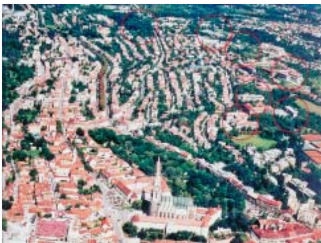
Pogled na Sjeverni kampus sa juga (planirane gradnje označene krugom).
