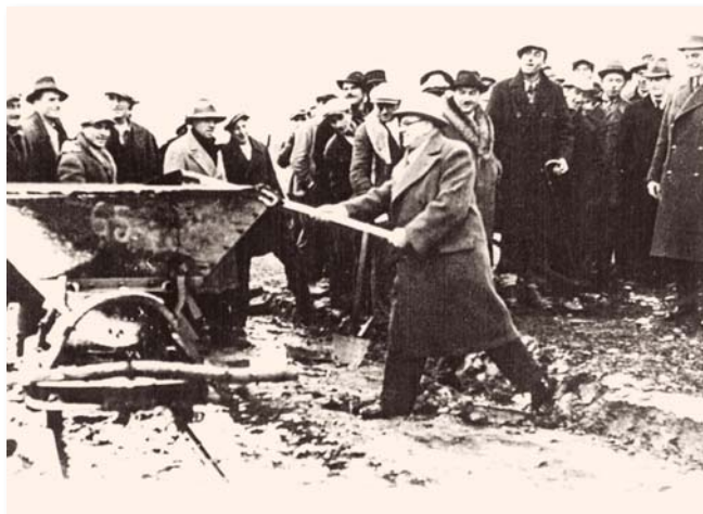
"Prva lopata" – radovi na izgradnji bolnice započeli su 19. prosinca 1935. godine
