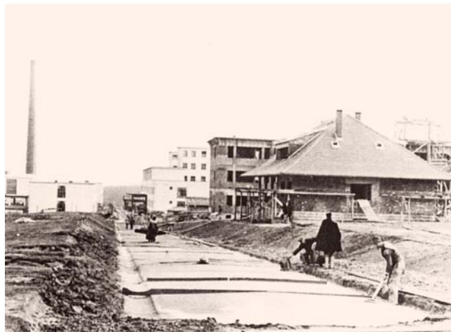
Radovi su nastavljeni tek u kolovozu 1936. godine
