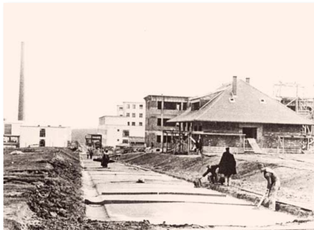
Radovi su nastavljeni tek u kolovozu 1936. godine
