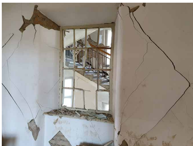
Slike 1a i 1b. Stanje zgrade Šalata 4. nakon potresa koji se dogodio 22. ožujka 2020.
