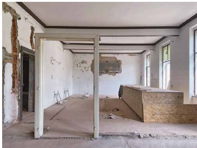
Zgrada staroga dekanata - obnova glavnog stubišta.
